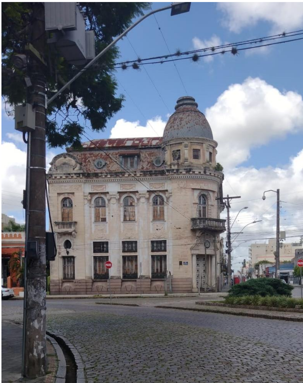
Um banco pelotense antigo – construção de 1928
